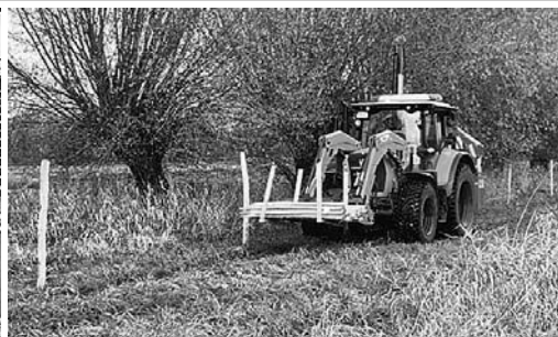
Unternehmen mit Unterstützung des Bauhofes setzen die Pfosten und ziehen die Drähte
