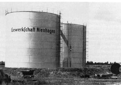
*Raky - Tankplatz: Die beiden Erdöltanks hatten jeweils einen Inhalt von 1500qm³. Wegen der Brandgefahr durch Tieffliegränge während des 2. Weltkrieges, wurden die Tanks auf einen Inhalt von 670qm³ verkleinert. 1970 wurde der Tankplatz Rückgebaut.*
