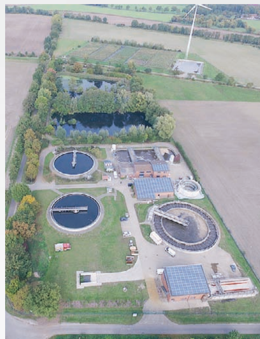
Im Vordergrund die erweiterte Kläranlage mit Rechengebäude und Sandfang (unten rechts im Bild), dem alten und neuen Belebungsbecken (oben- und unterhalb des Betriebsgebäudes), den Nachklärbecken (Bildmitte links) und den dahinter geschalteten Schönungsteichen. Oben im Bild die fünf Vererdungsbeete und die Windkraftanlage.
