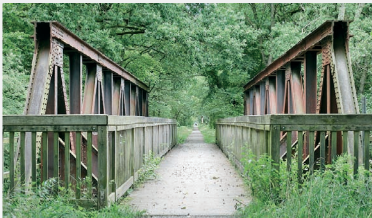
Alte Eisenbahnbrücke über die Aue bei Nienhagen
