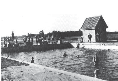
Das 1938 erbaute Nienhager Schwimmbad an der Fuhse mit Pumpenhäuschen
