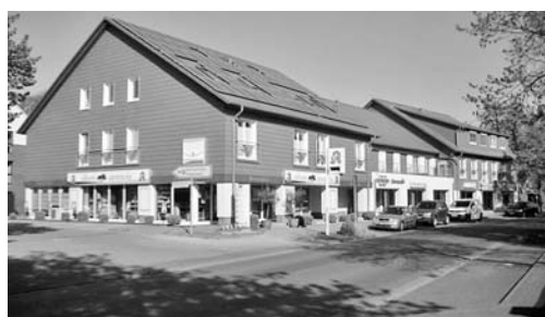
Ansicht von der Dorfstraße
