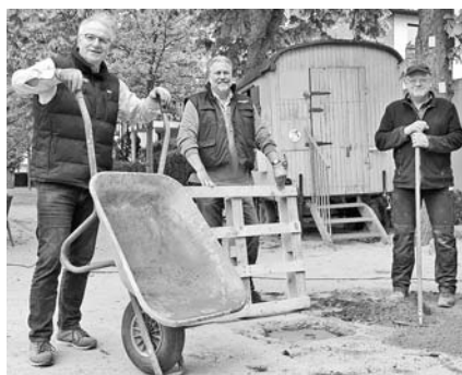
Betonierung der Sonnenschirm-Bodenröhren
