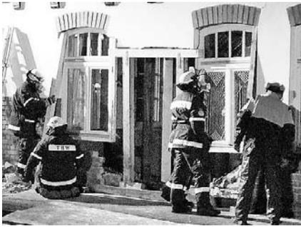
Das Technische Hilfswerk aus Celle konnte mit seinen umfangreichen und großen Gerätschaften, sowie Holzbalken, Plane und Holzplatten das klaffende Loch in der beschädigten Hauswand abstützen und verschließen.
