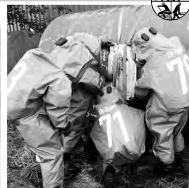
Vier Feuerwehrleute in Chemikalienschutzanzügen dichteten den Großtank mit Hilfe eines pneumatischen Leckdichtkissens ab.
