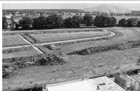
Beginn der Erschließungsmaßnahmen
