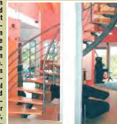
Freitragende Mittelholmtreppe als Bogentreppe mit modernem Rellingeländer
