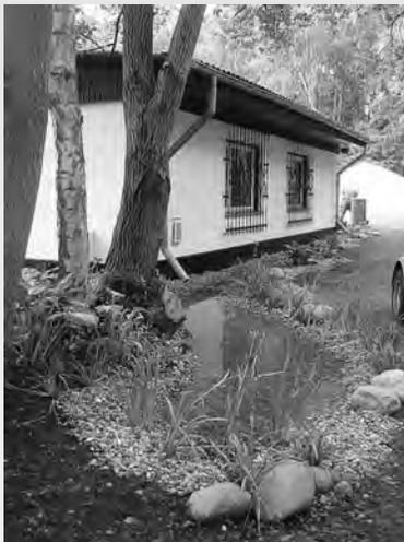
Auf den Grundstücken gibt es mehrere Möglichkeiten der Regenwasserversickerung bzw. Regenwassernutzung. Die Ableitung über Zisternschächte in den Untergrund ist nach dem neusten Stand der Technik veraltet und sollte nicht mehr gebaut werden. Die Reinigung des Wassers und der notwendige Abstand zum Grundwasser ist nicht gewährleistet, so dass es zu Verunreinigungen kommen kann.
